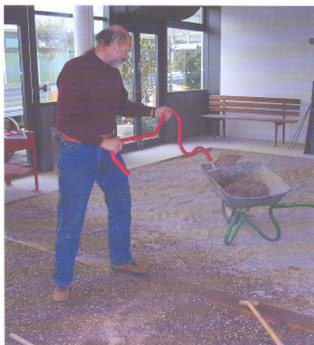
Grabarbeit mit der Spatenschaufel (Foto: Ergobase GmbH & Co. KG)
